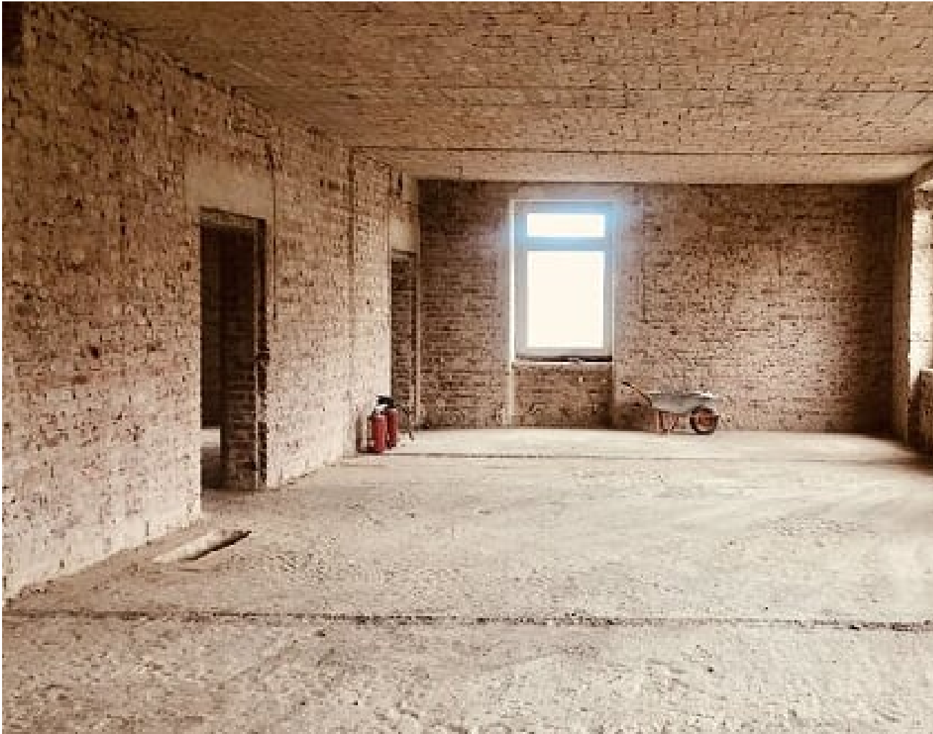
Das entkernte Gebäude Nr. 1
